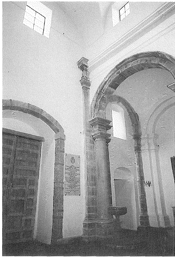
Naso. Santuario di San Cono; particolare della contro-faccata, dell'innesto della prima arcata e della relativa campata della navata minore.
