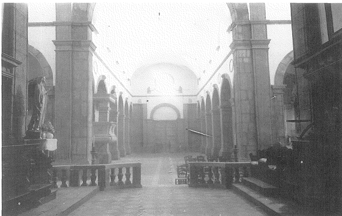
Trecastagni. Chiesa Madre; le foto mostrano la navata centrale quando ancora non erano stati completati i lavori di “scorticatura” delle strutture per liberarle dagli stucchi sette-ottocenteschi (Archivio Fotografico Soprintendenza di Catania).
