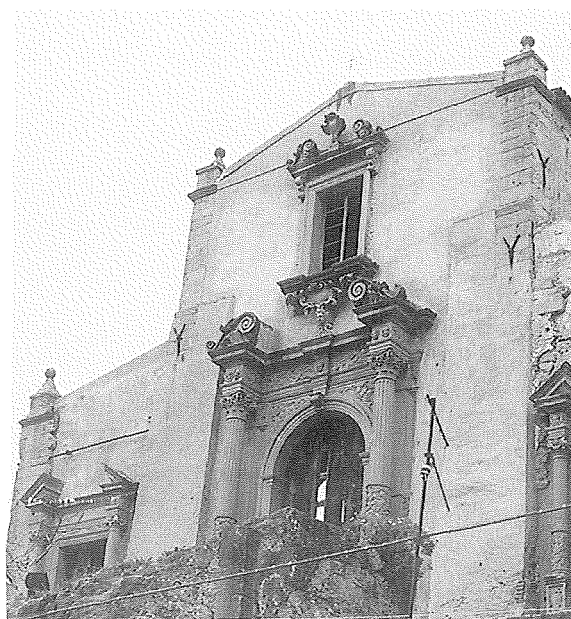
Sant'Angelo di Brolo. Chiesa del SS. Salvatore. Il prospetto.
