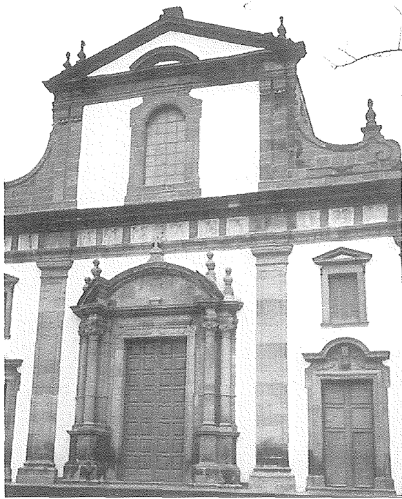
Randazzo. Chiesa di San Martino. La chiesa era di prerogativa della comunità lombarda; ricostruita alla fine del XVI secolo, ha, all'interno, una scansione in tre navate con colonne doriche. Nel prospetto è notevole l'introduzione nel fregio di formelle marmoree scolpite.
