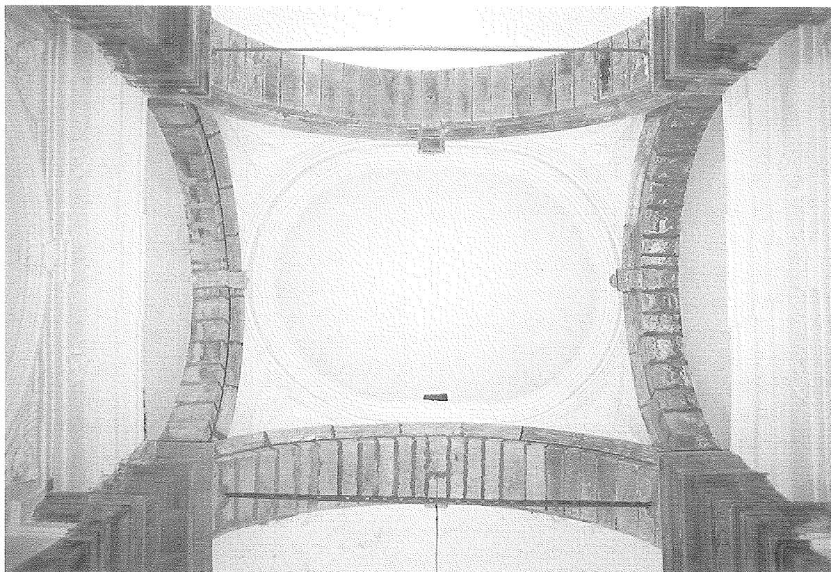
Naso. Santuario di San Cono; la cupola ellittica cieca vista dal basso: si notino gli arconi robusti ed i nodi strutturali che formano il telaio di base.
