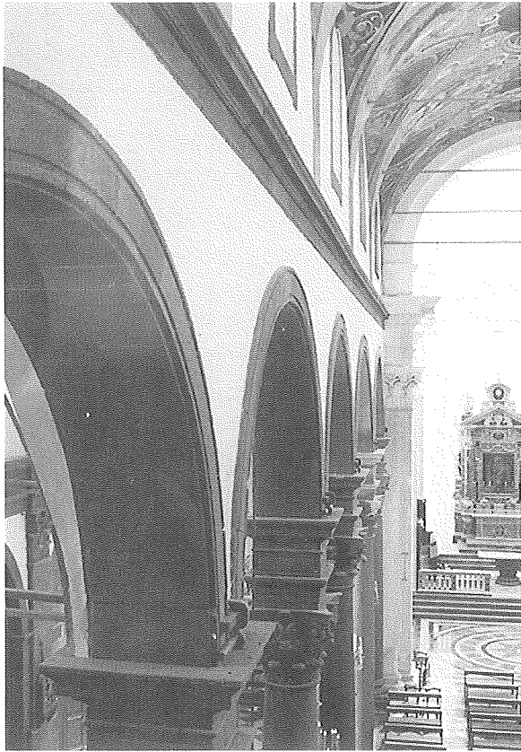
Randazzo. Chiesa di Santa Maria; scorci dell'interno: la teoria delle arcate ed il particolare della controfacciata.
