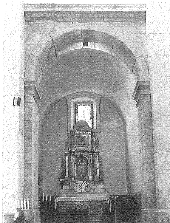
Particolare della scarsella laterale sinistra (cappella del SS.Sacramento) dove si conserva un pregevole ciborio ligneo del XVII secolo. Si noti la poderosa struttura arcuata che sottolinea l'affaccio sul transetto.
