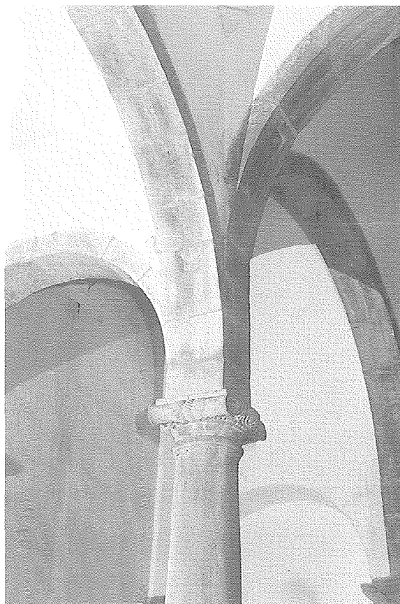
Tusa. San Giovanni. Particolare di una delle colonne del quadrato di base della crociera e dell'arrivo delle quattro arcate relative.
