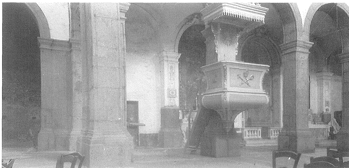
Trecastagni. Chiesa Madre; le foto mostrano la navata centrale quando ancora non erano stati completati i lavori di “scorticatura” delle strutture per liberarle dagli stucchi sette-ottocenteschi (Archivio Fotografico Soprintendenza di Catania).
