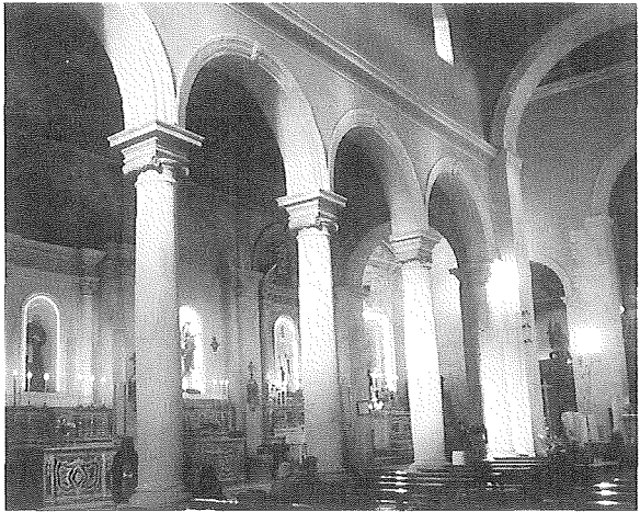
Monforte San Giorgio. Chiesa parrocchiale; particolare delle navate.
