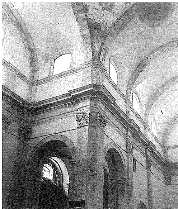
Milazzo. Duomo antico; interno: particolari del passaggio fra navata e transetto con al centro le arcate di affaccio di una delle piccole cappelle cupolate che si dispongono sullo spigolo della crociera.
