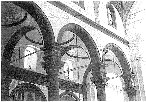
Randazzo. Chiesa di Santa Maria; particolare della navata maggiore all'innesto del transetto.
