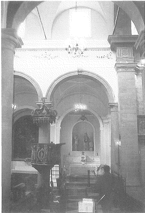
Galati. Chiesa parrocchiale (San Giacomo); particolari dei pilastri della crociera e dell'innesto fra navata centrale e presbiterio.
