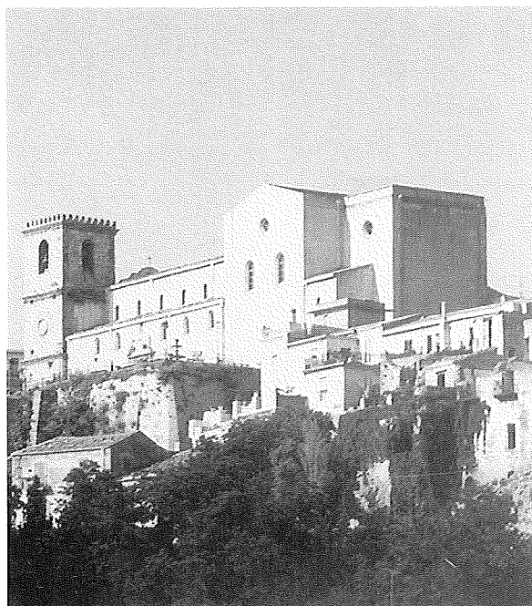
Castoreale. Chiesa Madre. Esterno: veduta posteriore dell'edificio. Si noti la contrapposizione fra volume longitudinale delle navate e volumi trasversali di transetto e scarsella.
