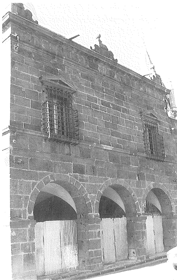
Randazzo. Chiesa di Santa Maria; la Tribonia : prospetto laterale.
