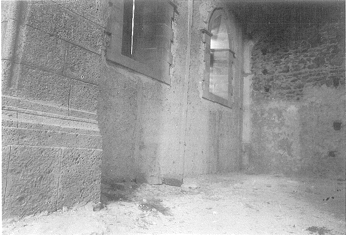
Trecastagni. Chiesa Madre; particolare della cappella di San Nicola quando erano in corso ampi lavori d'integrazione (Archivio Fotografico Soprintendenza di Catania).
